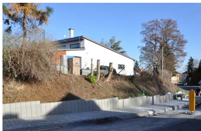
Výstavba chodníku na Třeboradické v Mírovicích SOUČASNOST
