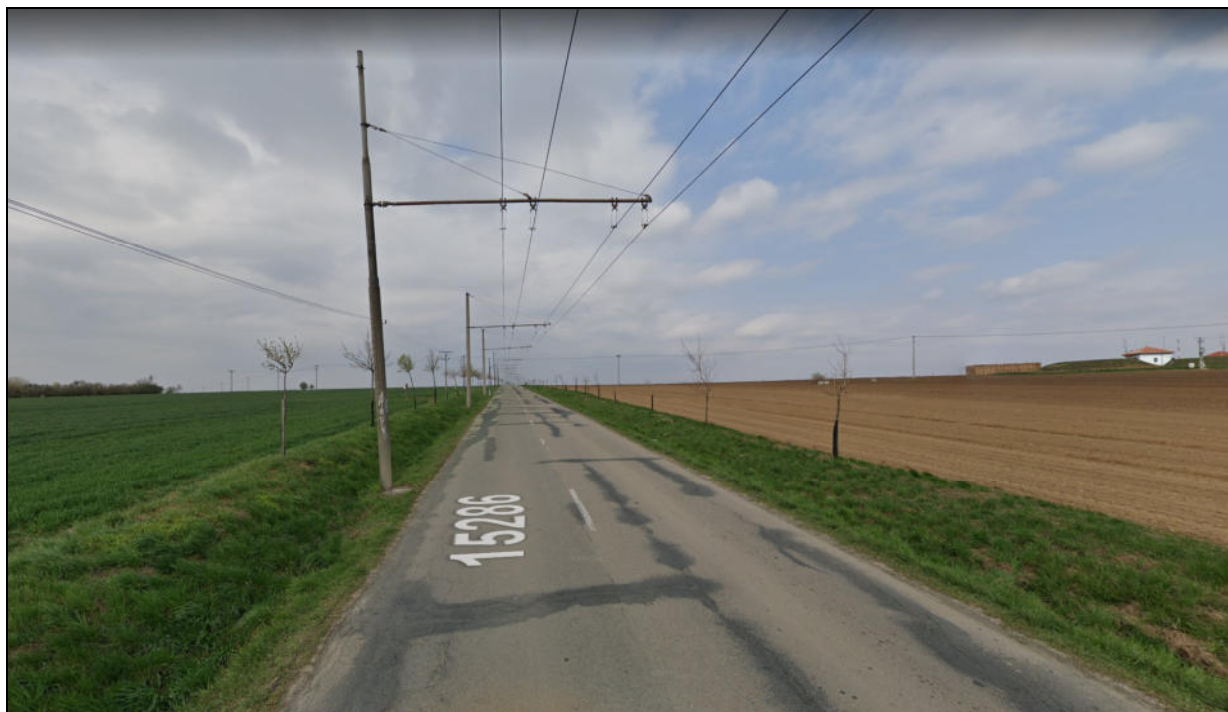
Obr. 14: Trolejové vedení ve volné krajině (ilustrační foto – Brněnská ul., Šlapanice, zdroj: Google mapy)
