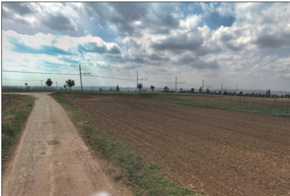
Obr. 13: Trolejové vedení ve volné krajině (ilustrační foto – Brněnská ul., Šlapanice, zdroj: mapy.cz)
