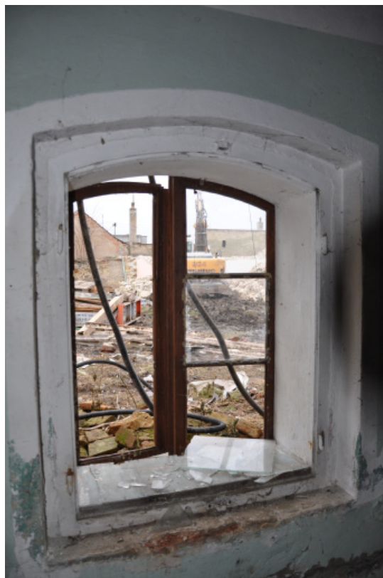
Bourací práce na statku
