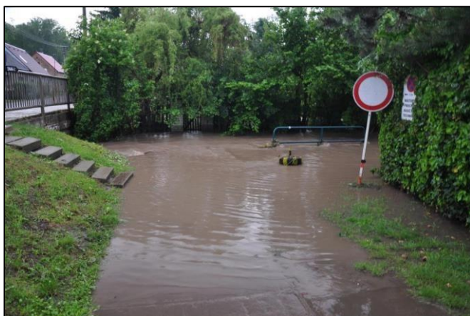
Záplava nad silničním mostem v ulici K Cihelně. Zaplavena je ul. Ke Mlýnu a ul. V Uličce
